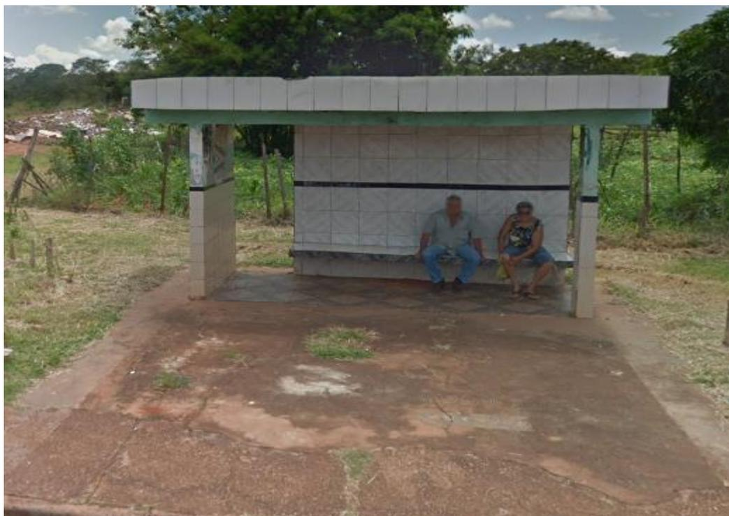
**Abrigo Concretado in loco / Argamassa**
