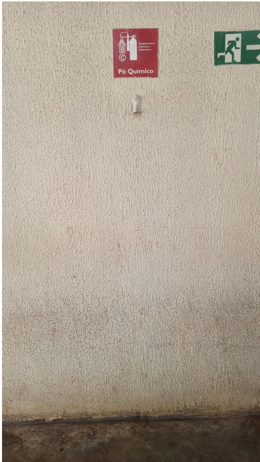
SINALIZAÇÃO DO EXTINTOR NO PISO E REPOSIÇÃO DO EXTINTOR
