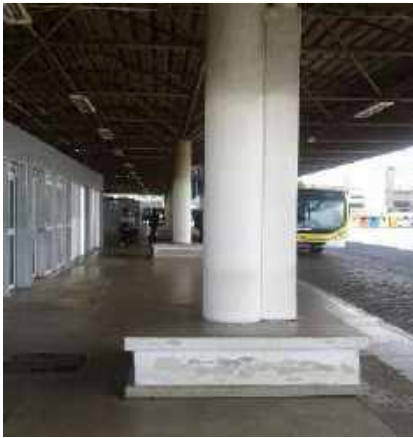
Esse é um dos nossos 12 pilares de sustentação do Terminal.
