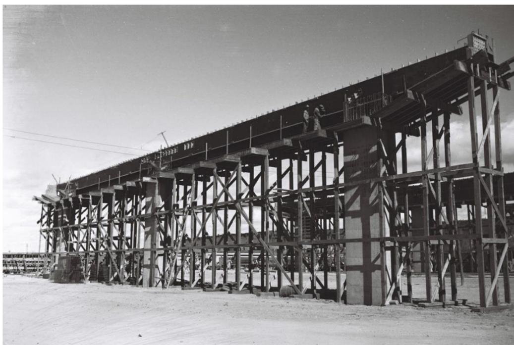
**Figura 15. Construção da linha de pilares com viga transversina protendida moldada in loco.**
