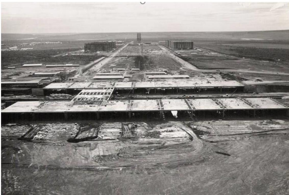
Figura 6. Construção da Plataforma Superior, em 1959. Fonte: Arquivo Público do DF
