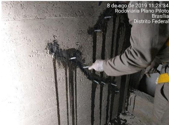
Figura 37. Injeção de fissura com resina epóxi.
