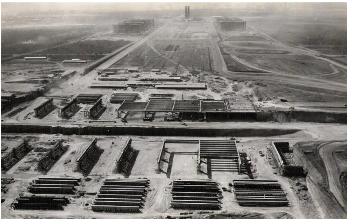
Figura 25. Disposição das vigas transversinas e longarinas. Fonte: Arquivo Público do DF
