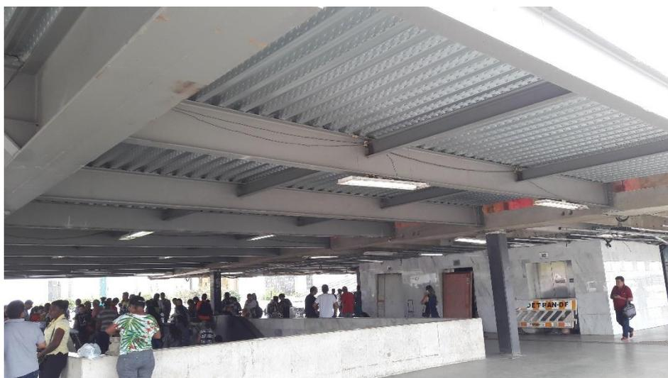
Figura 17. Plataforma Superior: estrutura metálica com laje *Steel Deck*. Fonte: Arquivo Consórcio.
