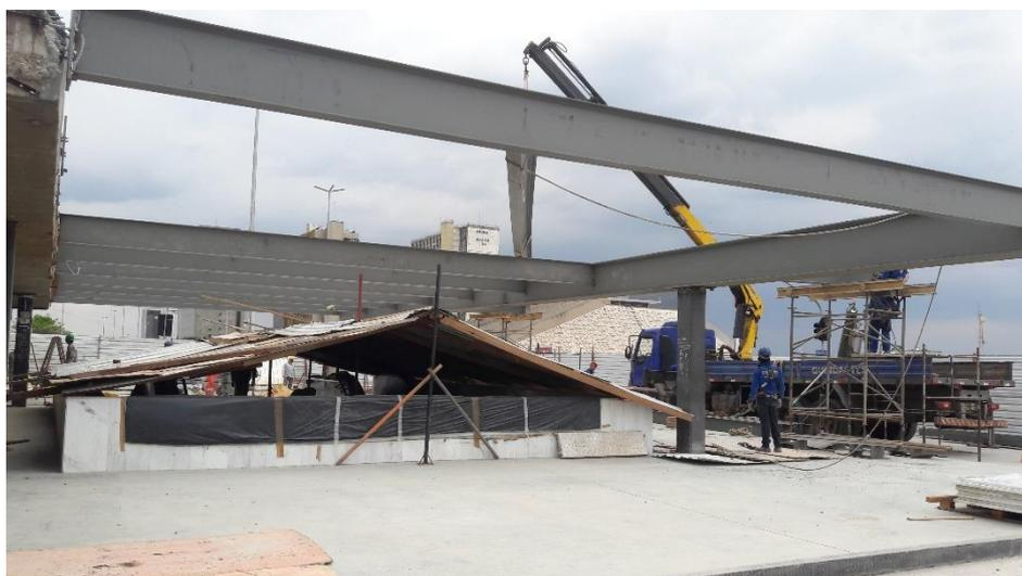
Figura 16. Plataforma Superior: execução da estrutura metálica. Fonte: Arquivo Consórcio.
