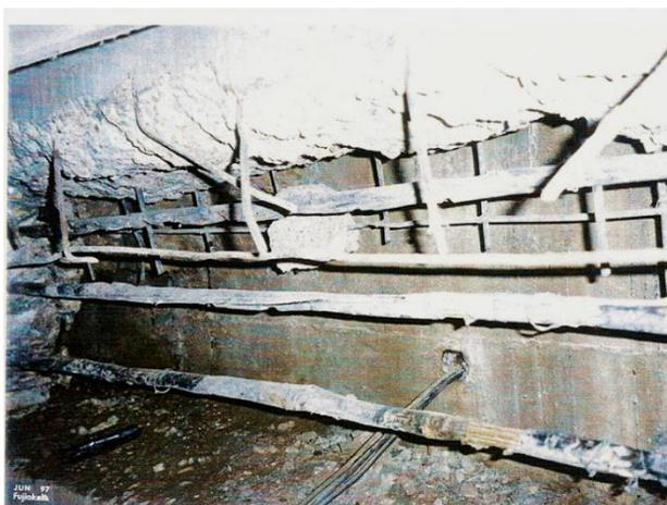
Figura 11. Recuperação de viga transversina com cabo de protensão em processo de corrosão, em 1997. Fonte: Arquivo Público do DF
