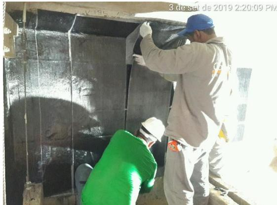
Figura 38. Aplicação de manda de fibra de carbono nas faces da viga. Fonte: Arquivo Consórcio.
