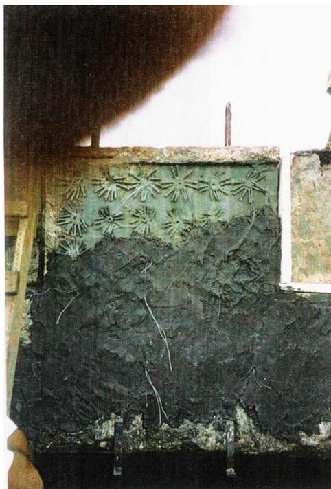
Figura 12. Recuperação das ancoragens dos cabos de protensão das vigas transversinas, em 1997. Fonte: Arquivo Público do DF
