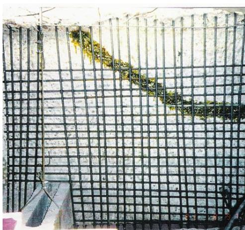
Figura 14. Reforço estrutural das vigas longarinas, na região do dente Gerber, em 1997. Fonte: Arquivo Público do DF
