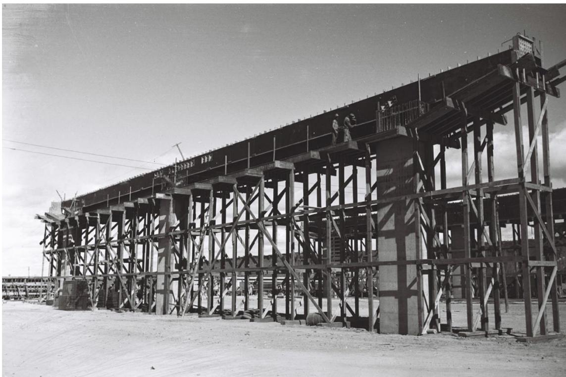
Figura 5. Construção da linha de pilares com viga transversina protendida moldada in loco. Fonte: Arquivo Público do DF
