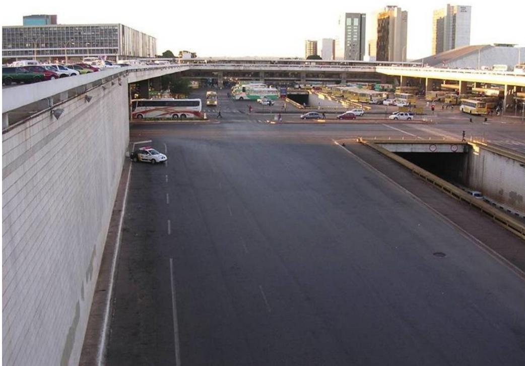
Figura 28 - Área Excessiva de Pavimento no Acesso ao ERS
