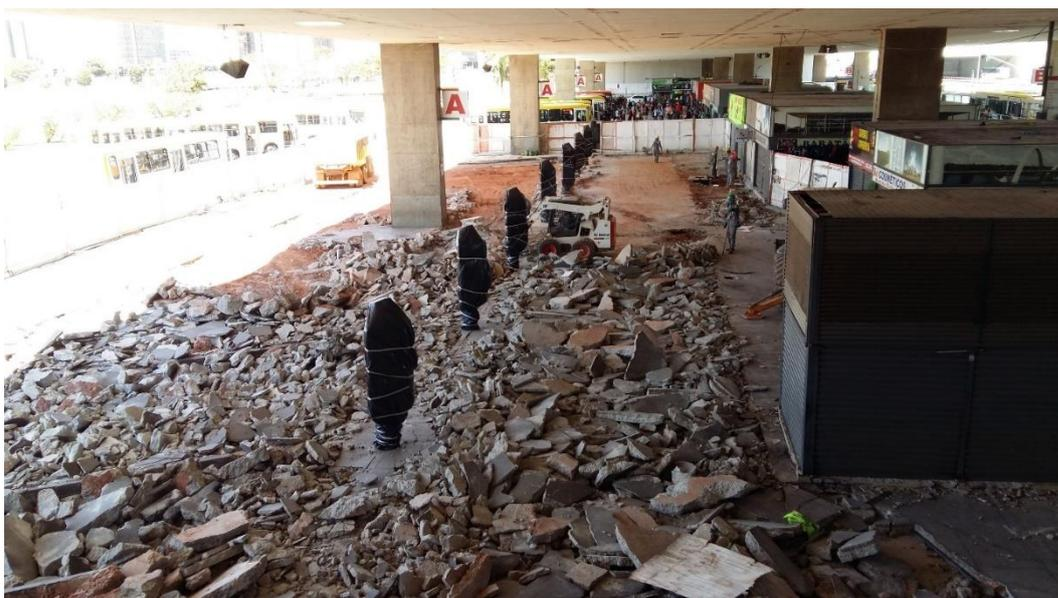
**Figura 16. Demolição do piso da Plataforma Inferior.**
