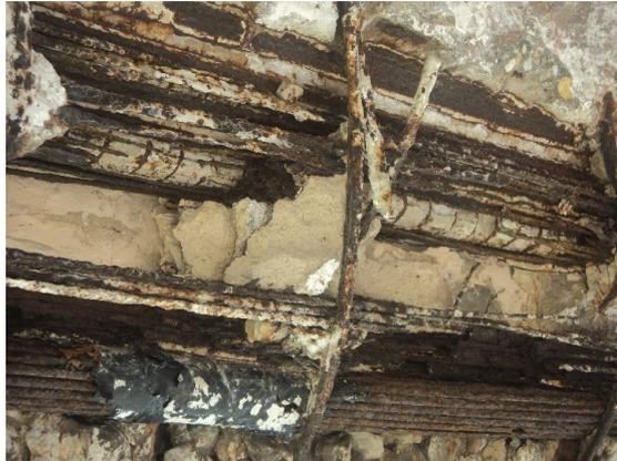
**Figura 23. Corrosão das cordoalhas de protensão das vigas longarinas.**
