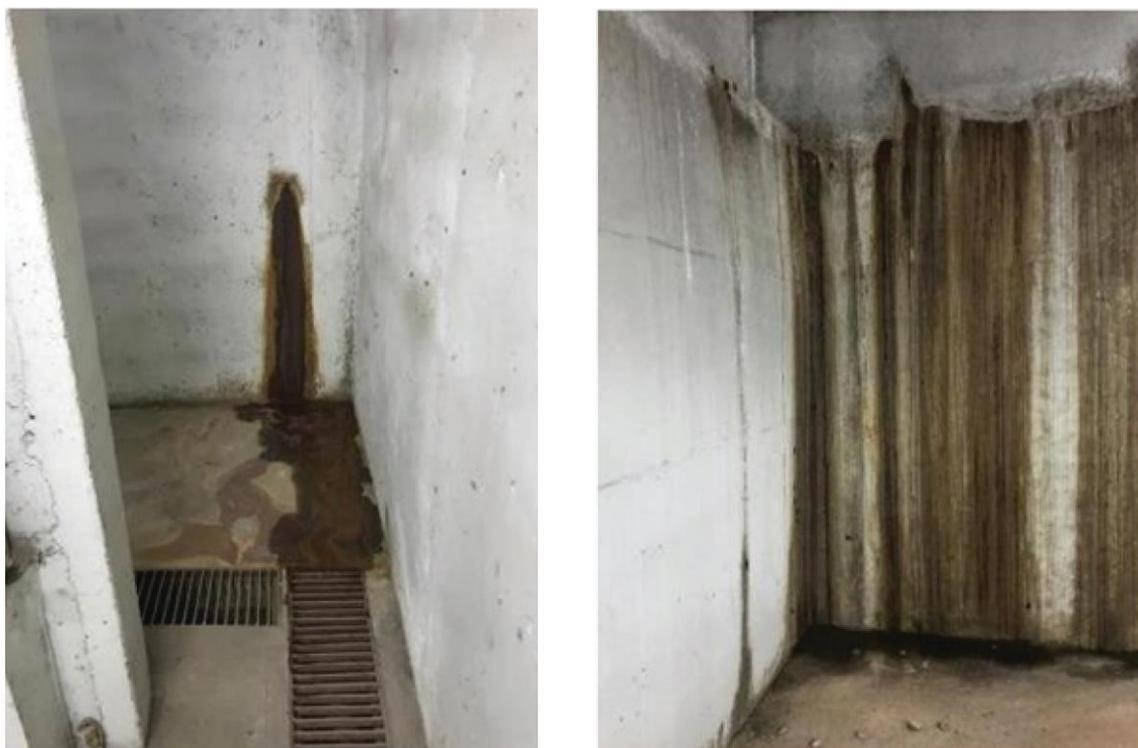
**Figura 27. Infiltrações nas paredes na área técnica no Subsolo.**
