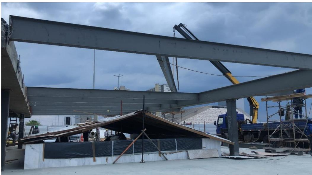
**Figura 4. Substituição das vigas de concreto por metálicas.**
