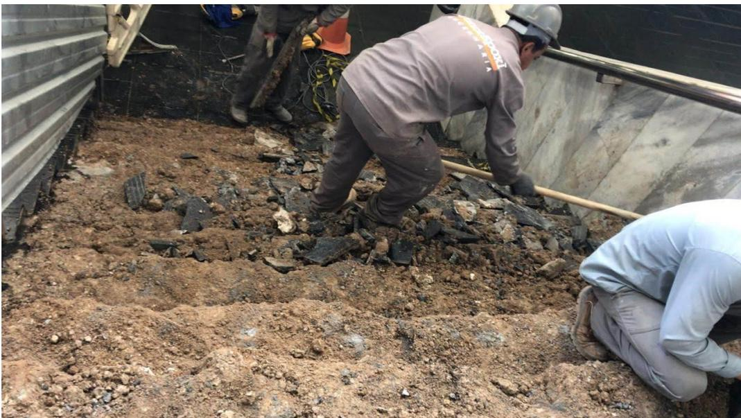
Figura 13. Substituição do piso em granito das escadas.
