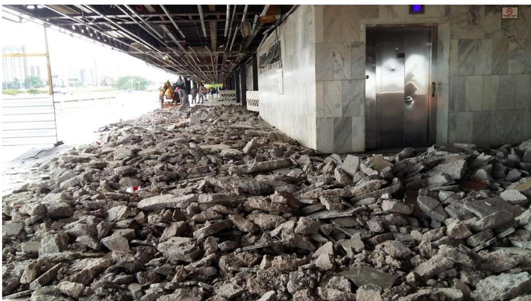
**Figura 8. Demolição do piso da Plataforma Superior.**
