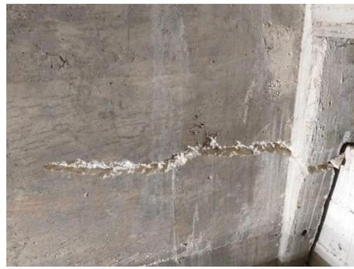
**Figura 26. Fissura no paio da viga.**
