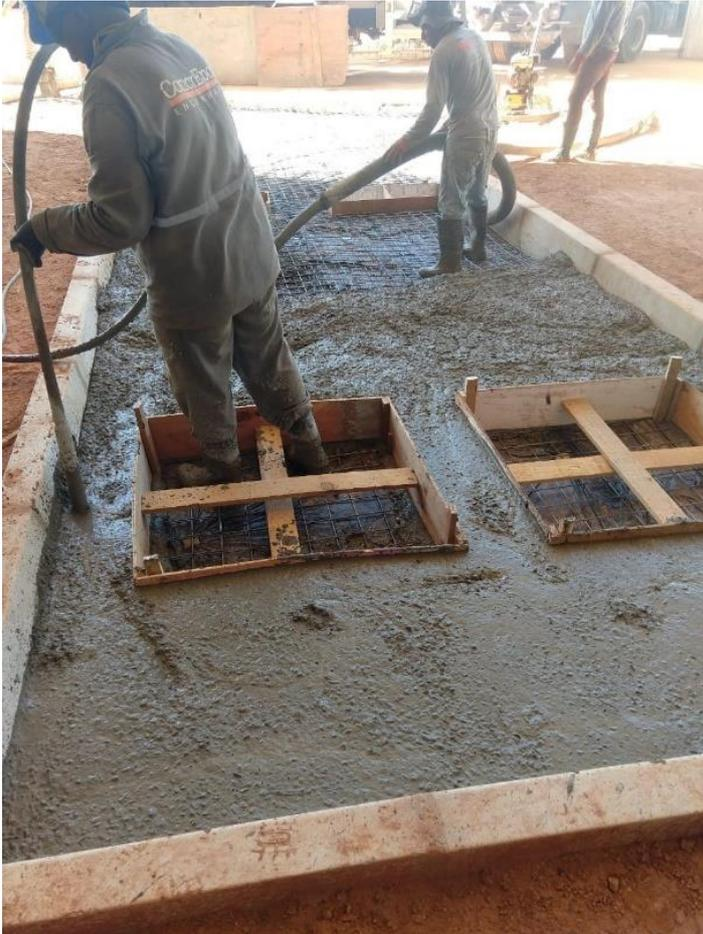
Figura 20. Concretagem do pavimento das baias de embarque das plataformas.
