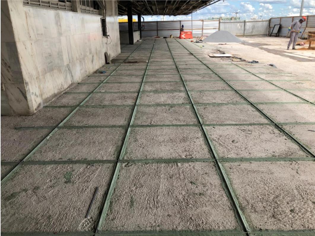
**Figura 9. Execução do contra piso da Plataforma Superior.**
