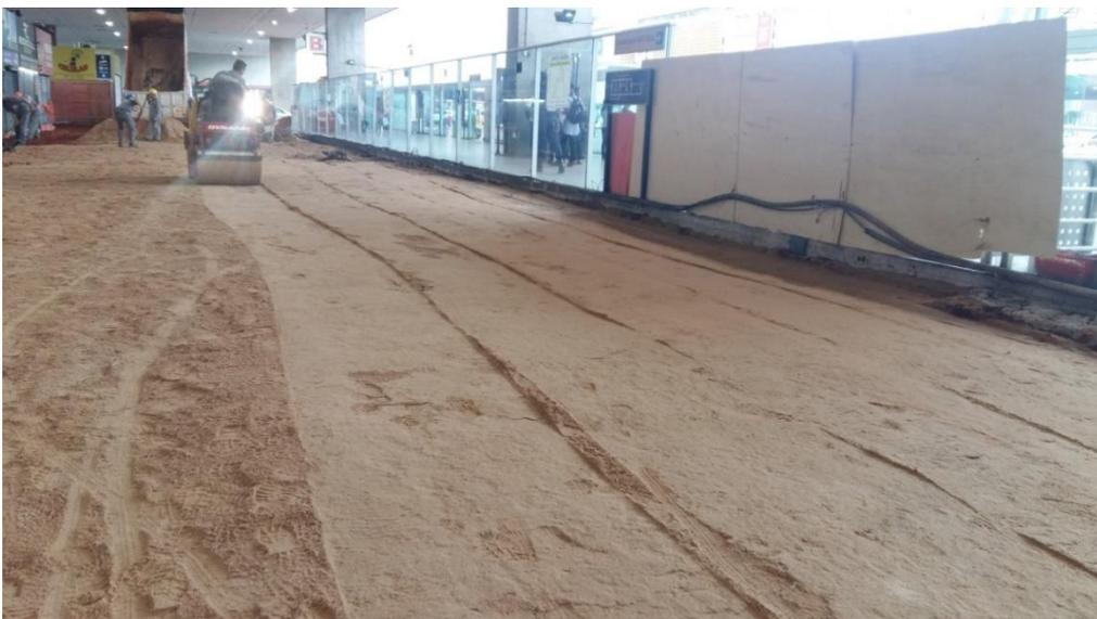
Figura 18. Reaterro do piso da Plataforma Inferior. Fonte: Arquivos do Consórcio
