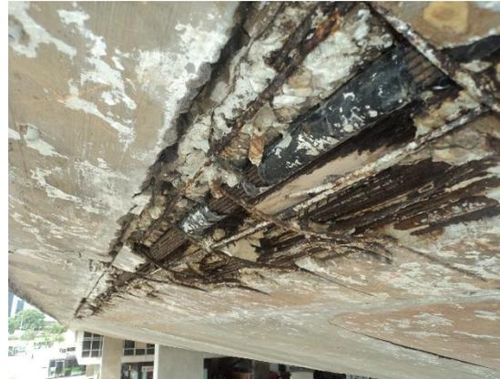
**Figura 24. Corrosão das cordoalhas de protensão das vigas longarinas.**
