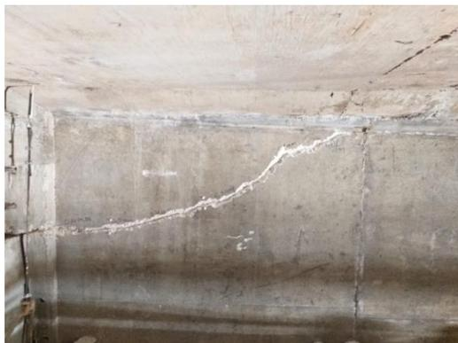
**Figura 25. Fissura no paio da viga.**
