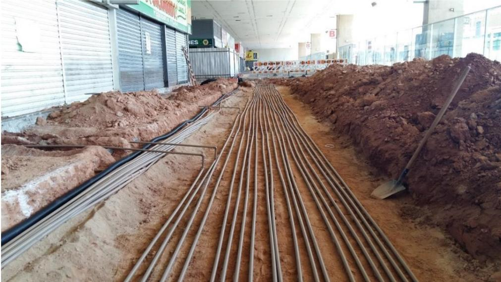
Figura 17. Execução de instalações sob o piso. Fonte: Arquivos do Consórcio
