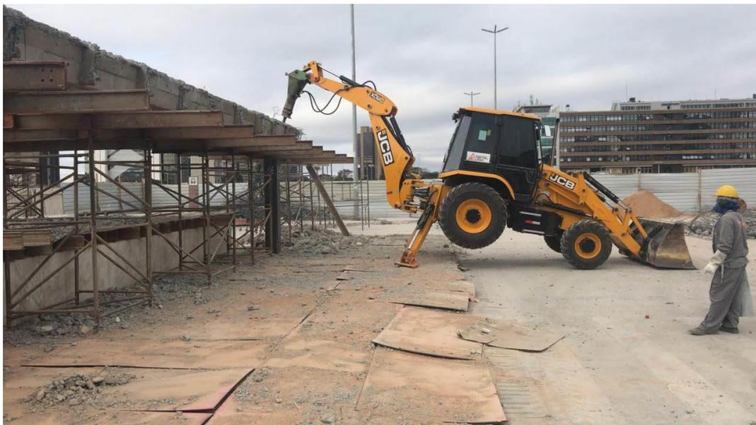
**Figura 3. Demolição da laje de cobertura da plataforma superior.**
