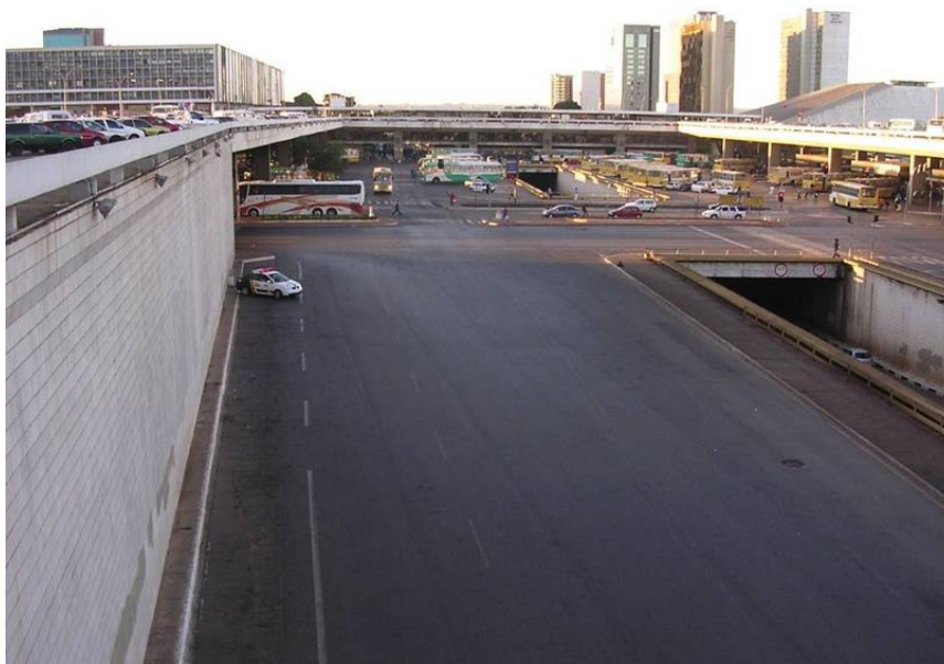
Figura 13. Área Excessiva de Pavimento no Acesso ao ERS
