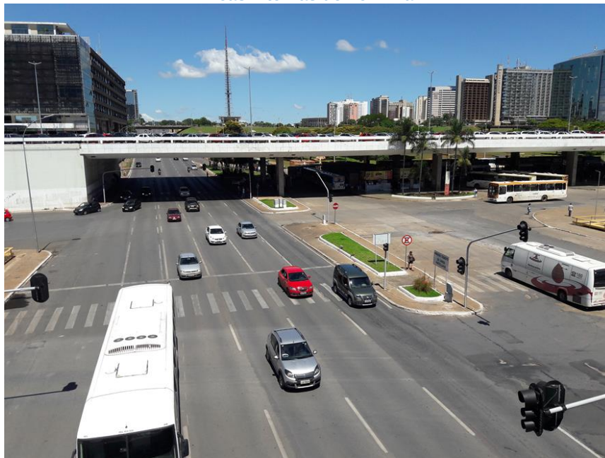
Figura 11. Ausência de Marcas Viárias no Acesso ao ERS e Áreas Internas do Terminal
