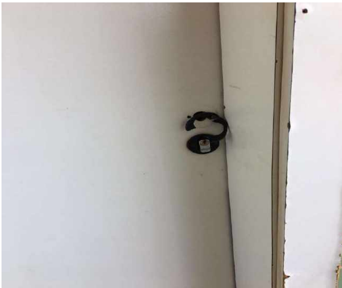
FECHADURA QUEBRADA
