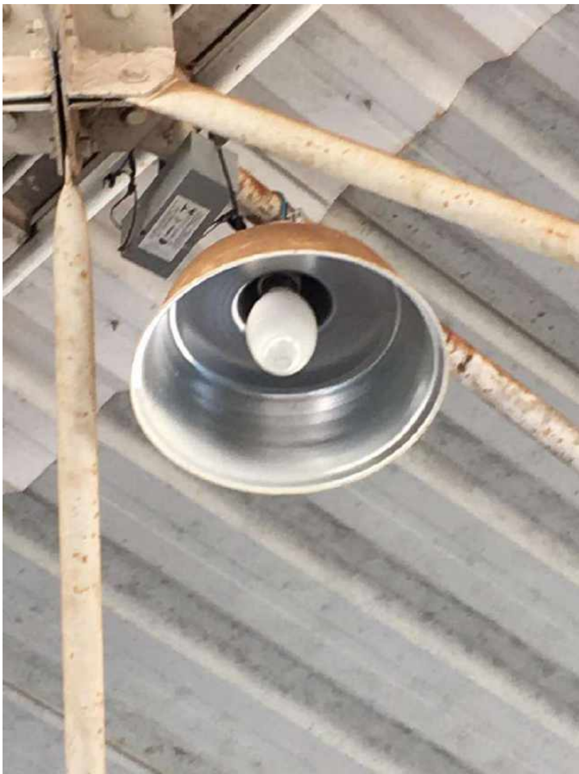
LÂMPADAS E REATORES QUEIMADOS
