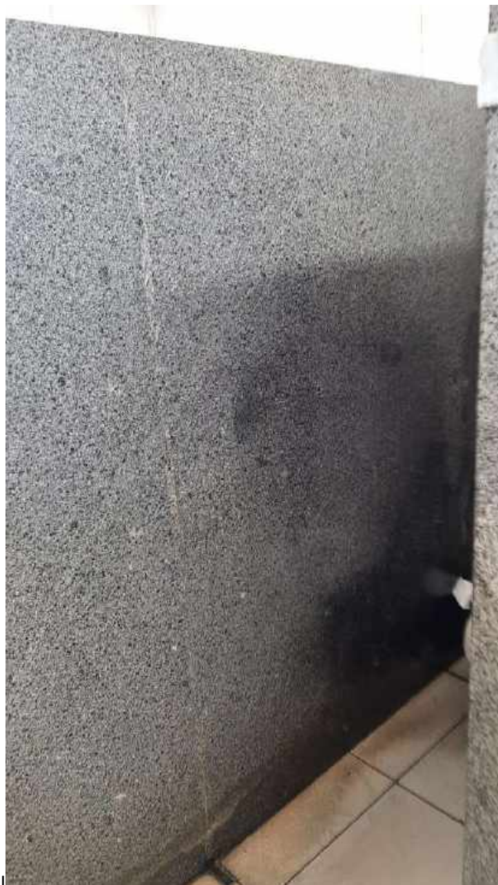
BANHEIRO SEM PORTA
