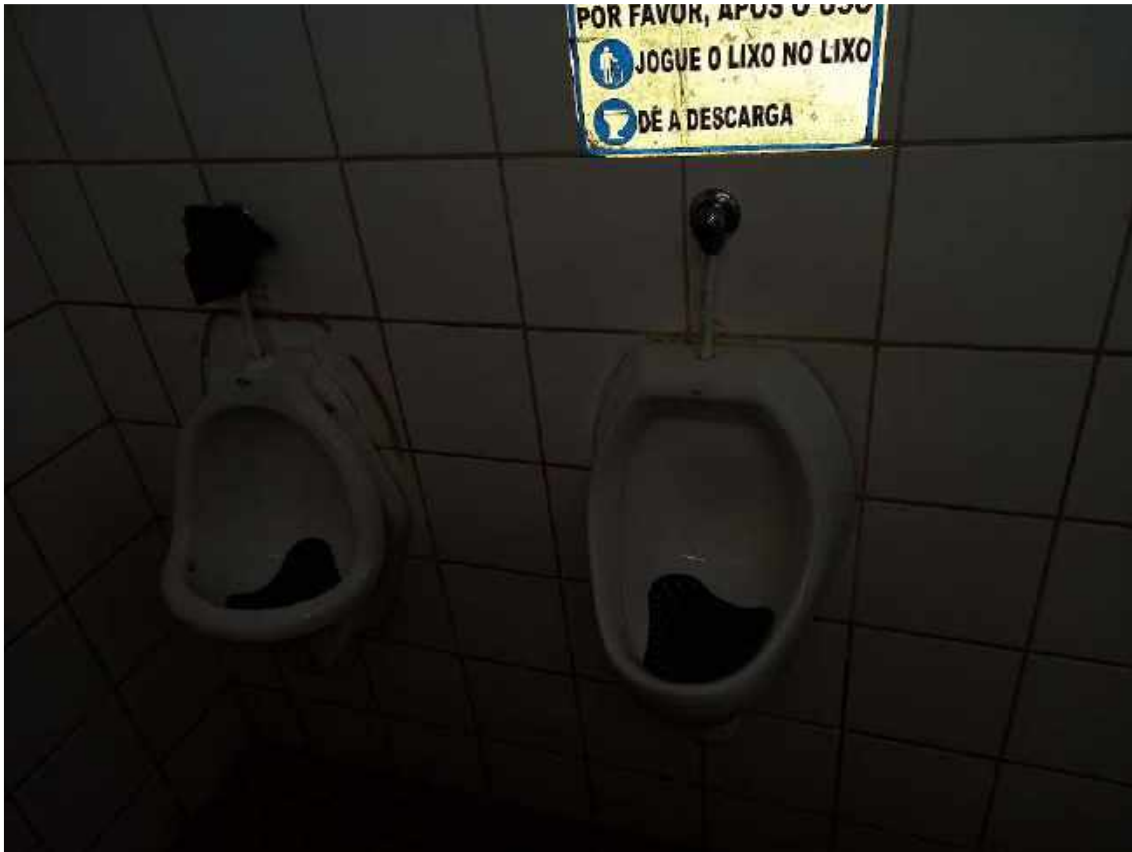
MICTÓRIOS COM ENTUPIMENTOS CONSTANTES 1
