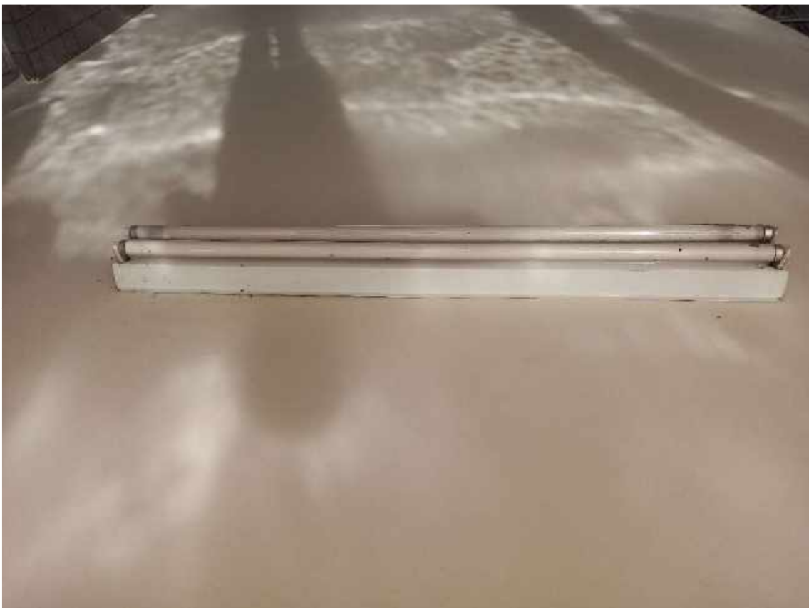
LÂMPADA TUBULAR DE 40W 1
