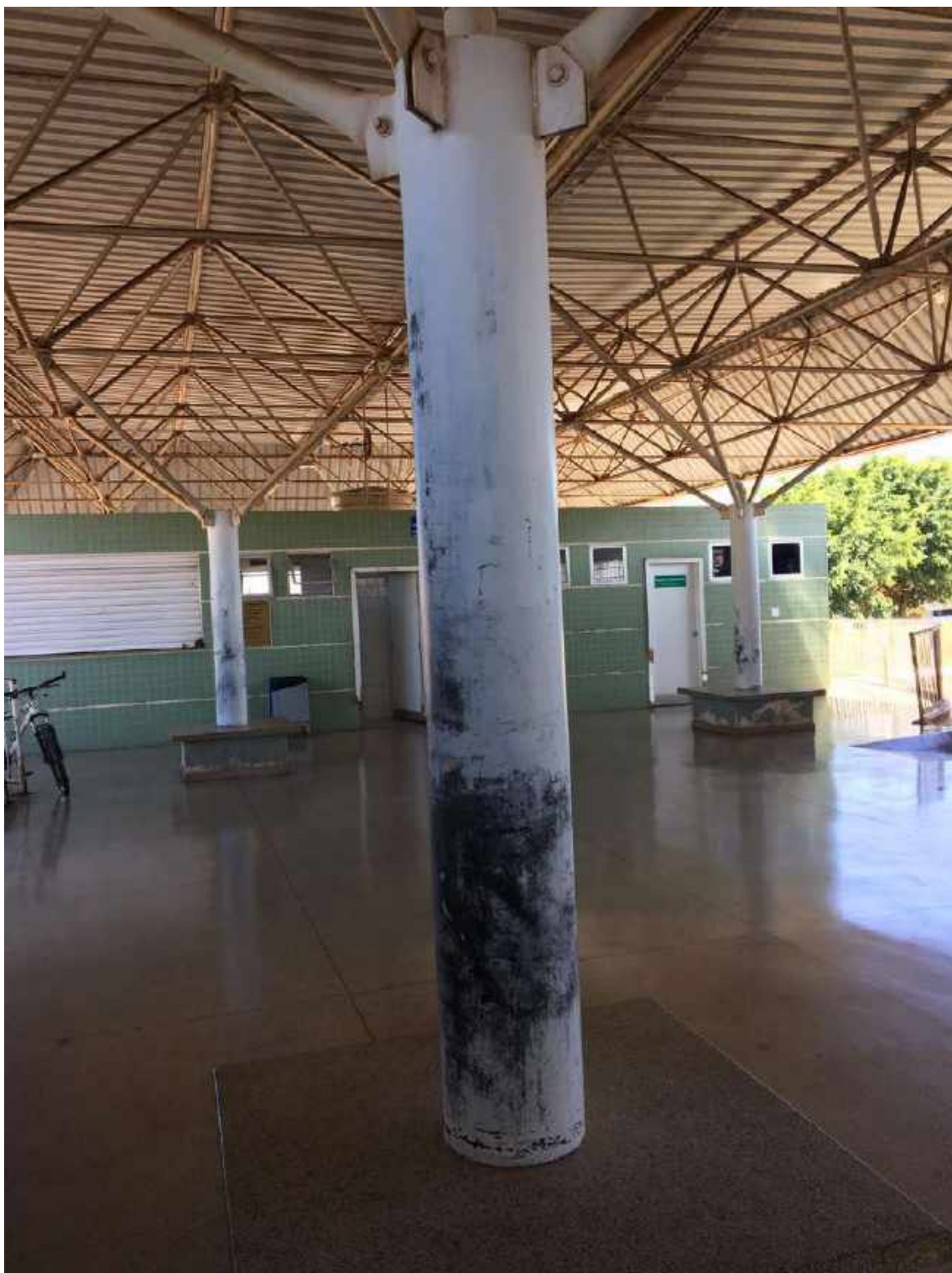
PINTURA DE PILARES E DE TODO O TERMINAL
