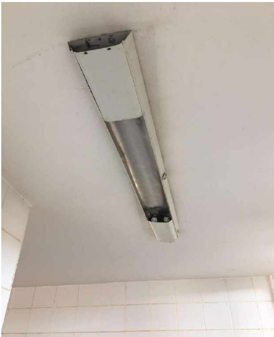
LÂMPADAS E REATORES QUEIMADOS
