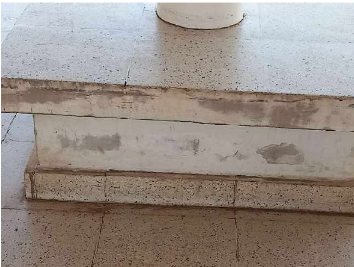
BASE DOS PILARES (PINTURA) 1
