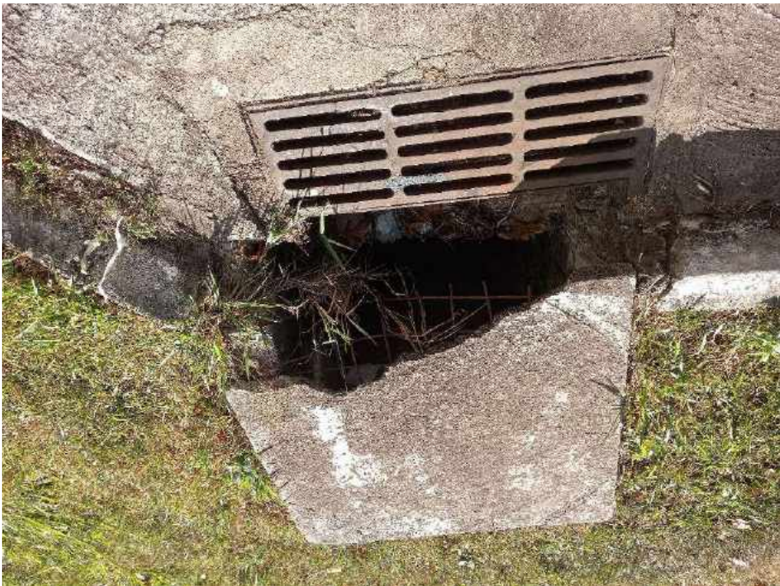
TAMPA DE ÁGUA PLUVIAL 1
